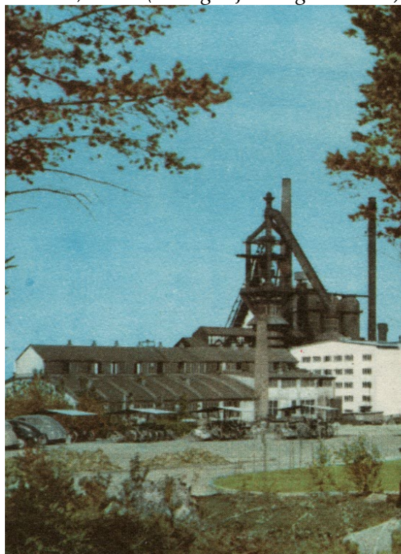
NJA:s järnbruk (nuvarande SSAB) på Svartön, Luleå (Sveriges Järnvägsmuseum)
